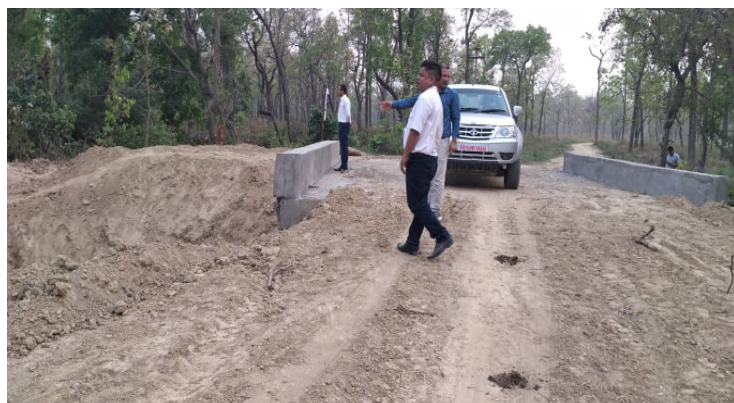
वडा नं. १० को मोतिपुर-धरमपुर जोड्ने सडकमा पुल निर्माणको अवलोकन गर्दै
